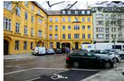
Abb. 64: Hackenplatz, Blick Richtung Süden
