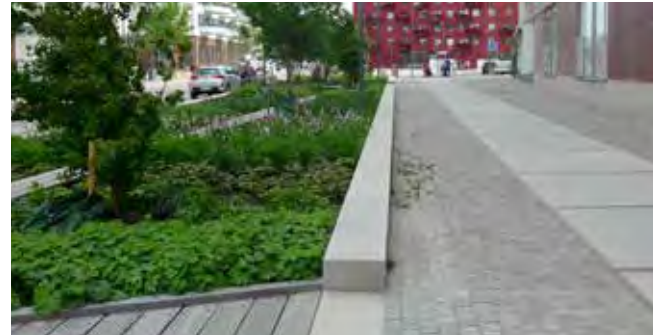
Abb. 22: Straßenbegleitende Retentionsmulden, Stockholm
