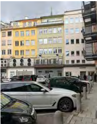
Abb. 121: Blick nach Norden/Nordwesten
